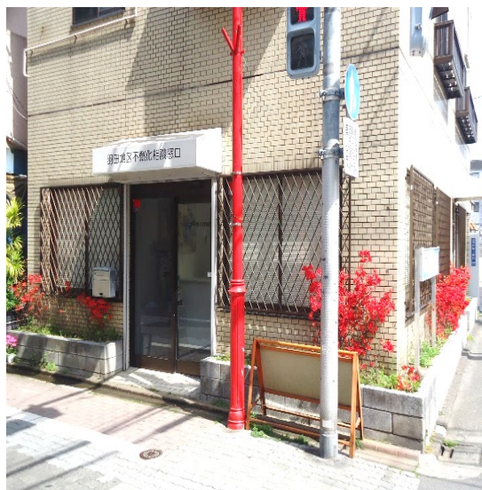
【相談窓口建物外観】
